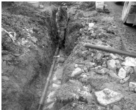
Oprava poruchy vodovodu, archiv obce
