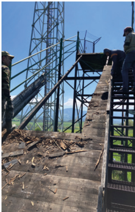
Rozebírání můstku K19
