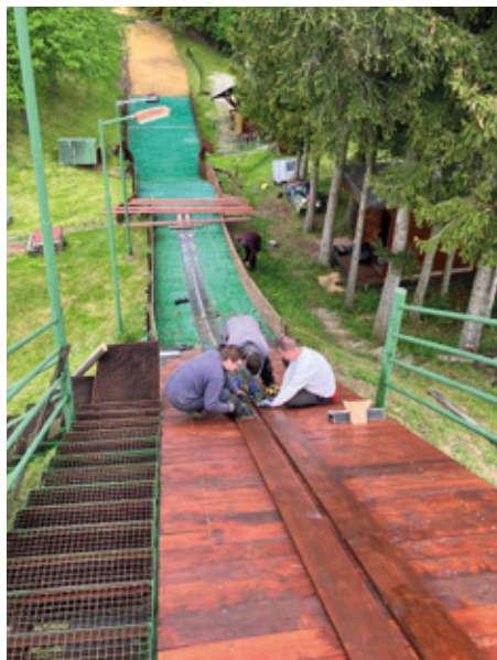
Rekonstrukce můstku K19
