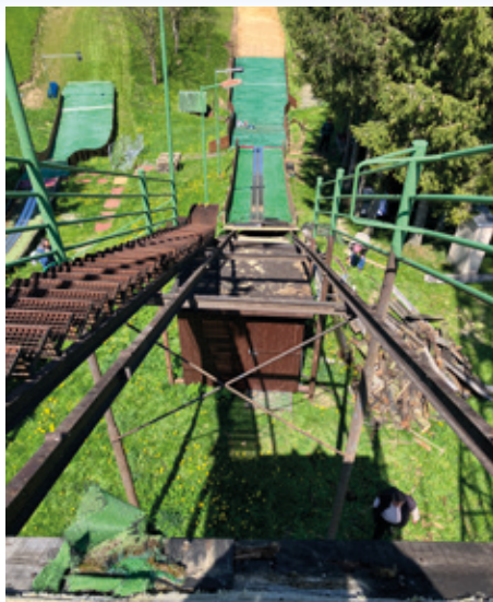
Odstranění staré výřevy
