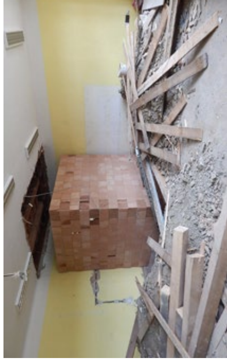
Přístavba ZŠ - výtahová šachta (archiv obec)
