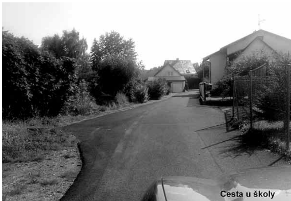
Úpravy po kanalizaci
