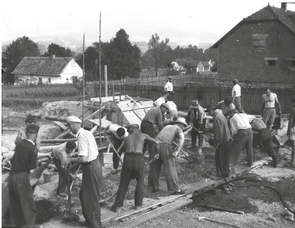
Stavba vodojemu pod Strážnicí, 12. 8. 1950
