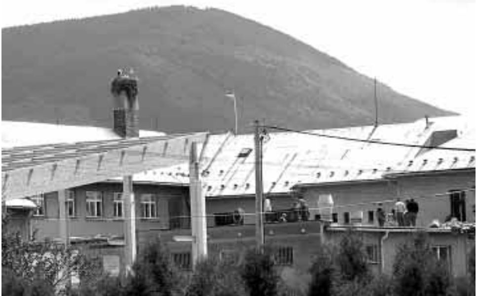
Nadstavba školní jídelny
